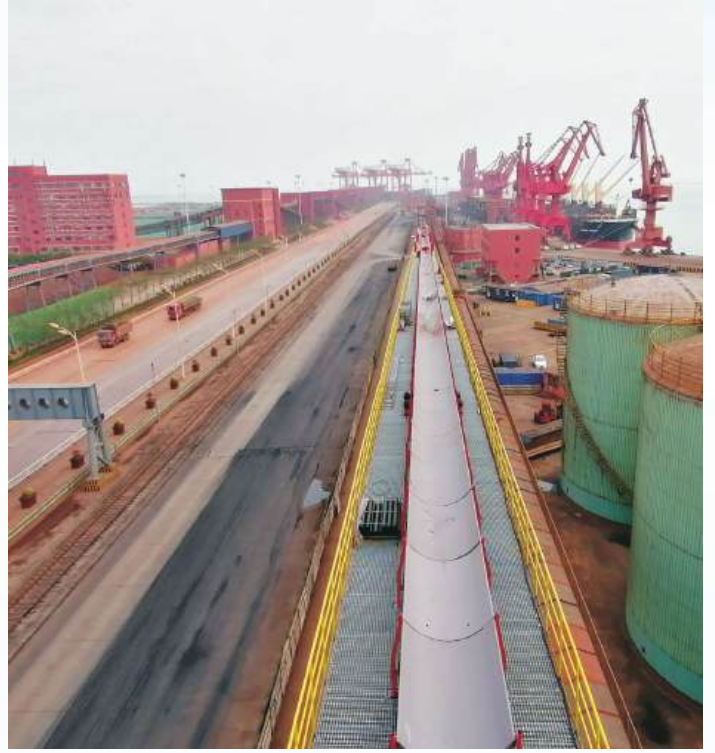
Lanshan liman bölgesinde dökme tahıl depolama ve taşıma sistemi yenileme ve genişletme projesinin ilk aşaması çift hatlı boşaltma projesi. 6 adet bantlı konveyör, 1400mm bant genişliğinde, 3.15m/s bant hızında, 1200T taşıma kapasitesine ve toplam 1.48km uzunluğundadır.
