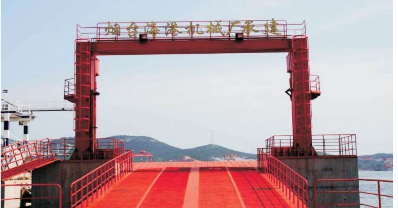
Ro-Ro bağlantı köprülerimiz - Ro-Ro Connecting Bridge
