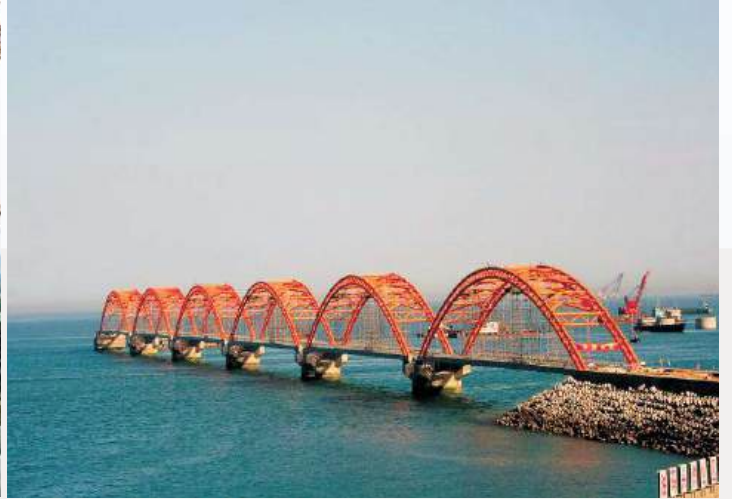
Çelik Köprü İmalatı Steel bridge manufacture
