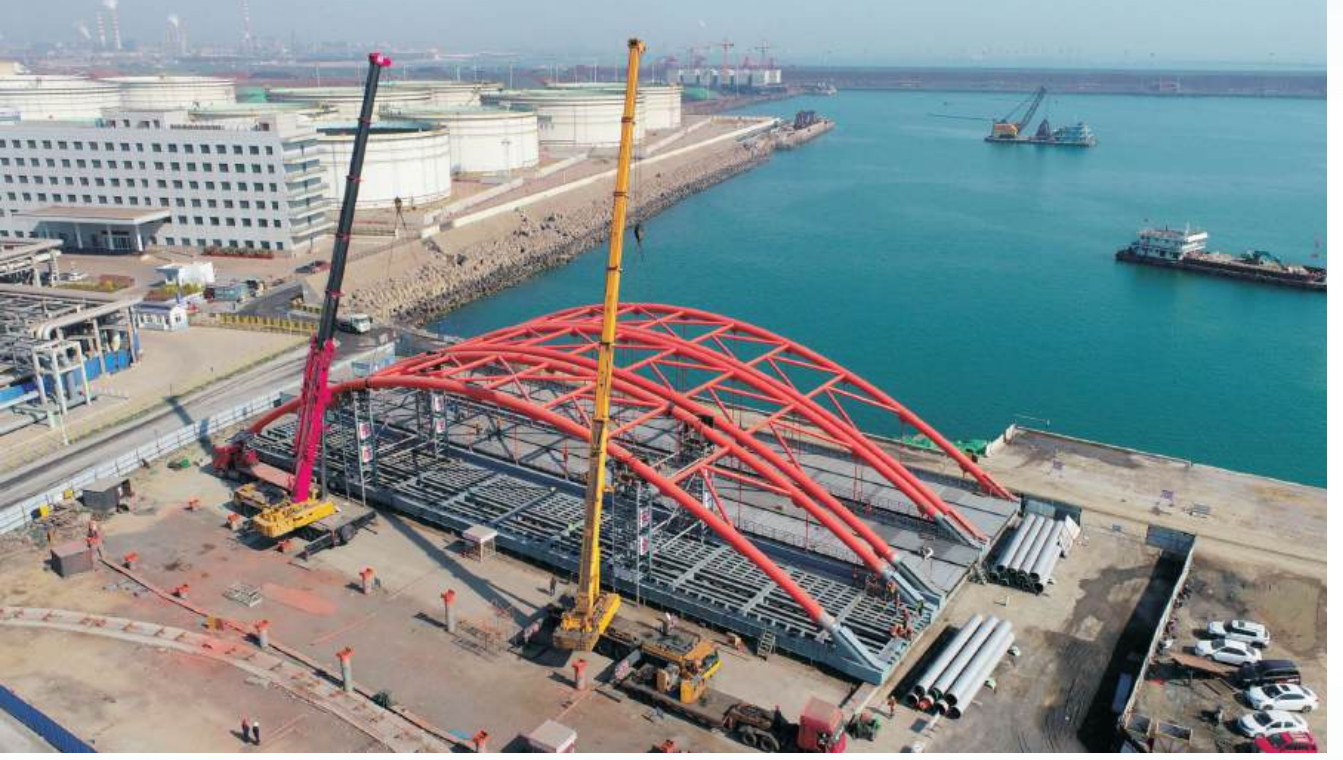
Lanshan Limanı 300.000 Tonluk Petrol Terminali Çelik Bağlantı Köprüsü Lanshan port 300,000 tons of oil terminal steel bridge
