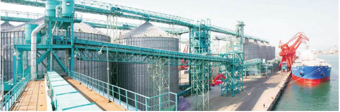
Tahıl Siloları için çelik yapı platformları Grain silo steel structure trestle
