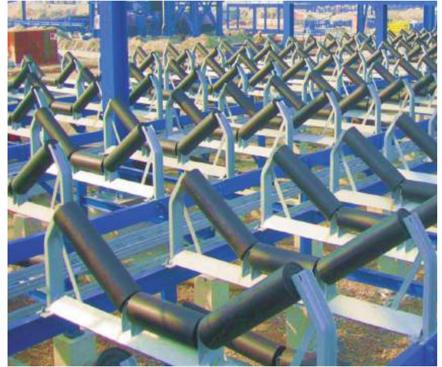
Avara montajı - SDIC Caofeidian kömür rıhtımı bantlı konveyör projesi Idler installation - SDIC Caofeidian coal wharf belt conveyor project
