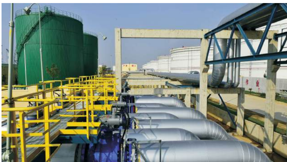
Petrokimya boru hattı kurulumları Petrochemical pipeline installation
