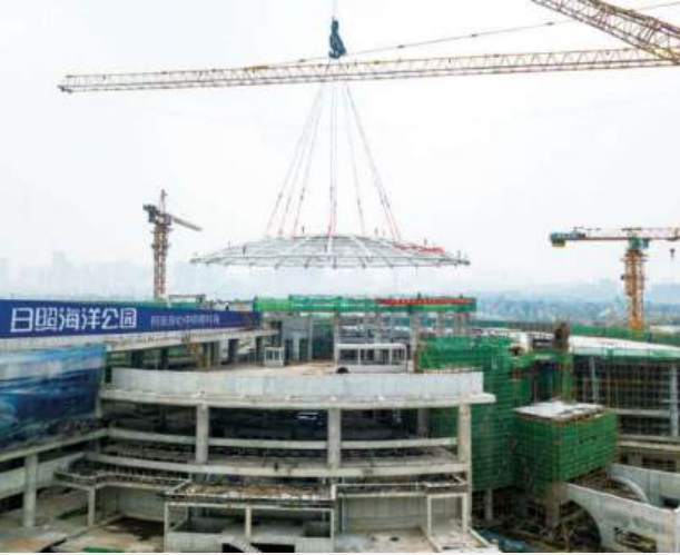
Rizhao Şehri Okyanus Parkı Çelik Yapı Projesi Toplam inşaat alanı 36.800 metrekare ve toplam kullanılan çelik miktarı 2.400 tondur.
