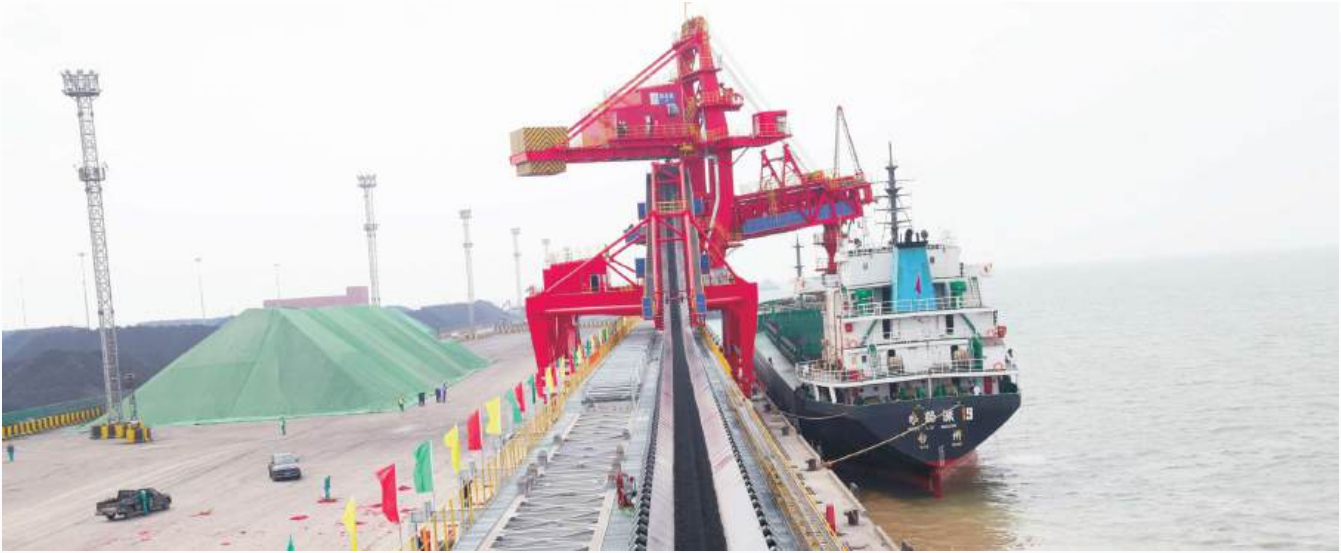
Rizhao Limanı'nın doğu-güney kömür transferi geri kazanım ve yükleme hattının bantlı konveyör sistemi Belt conveyor system of Rizhao Port east-to-south coal transfer reclaiming and loading Line
